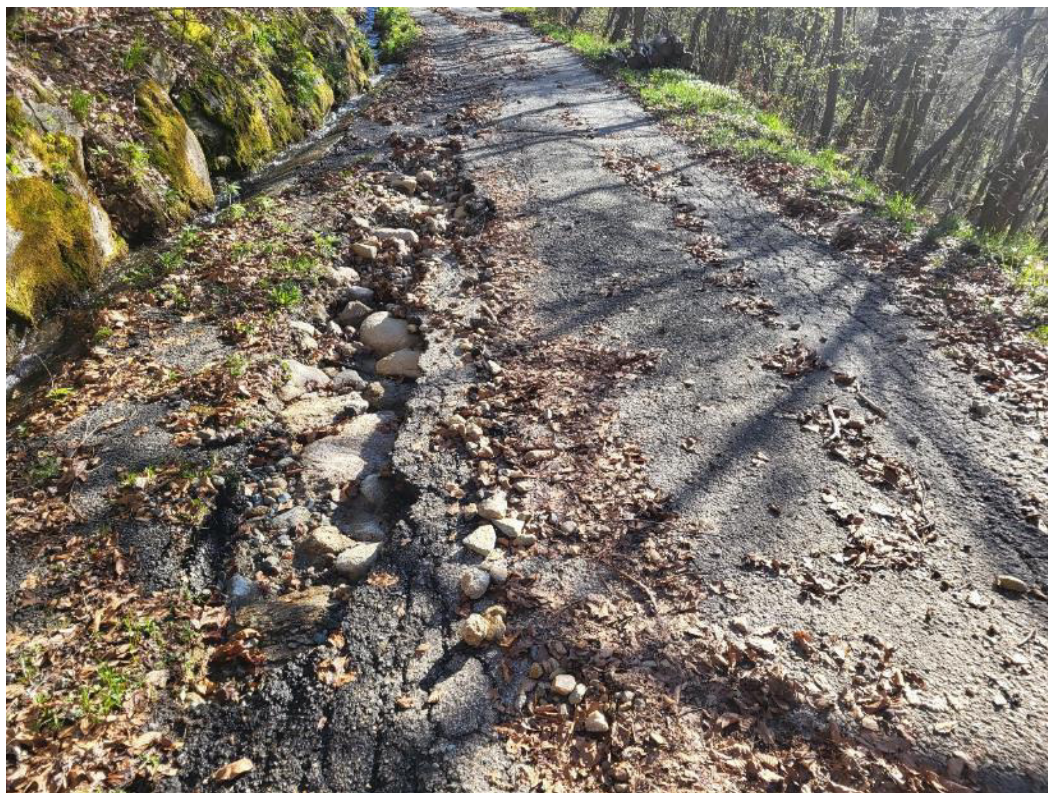
Foto 14: importanti cedimenti superficie stradale da ruscellamento sotterraneo.
