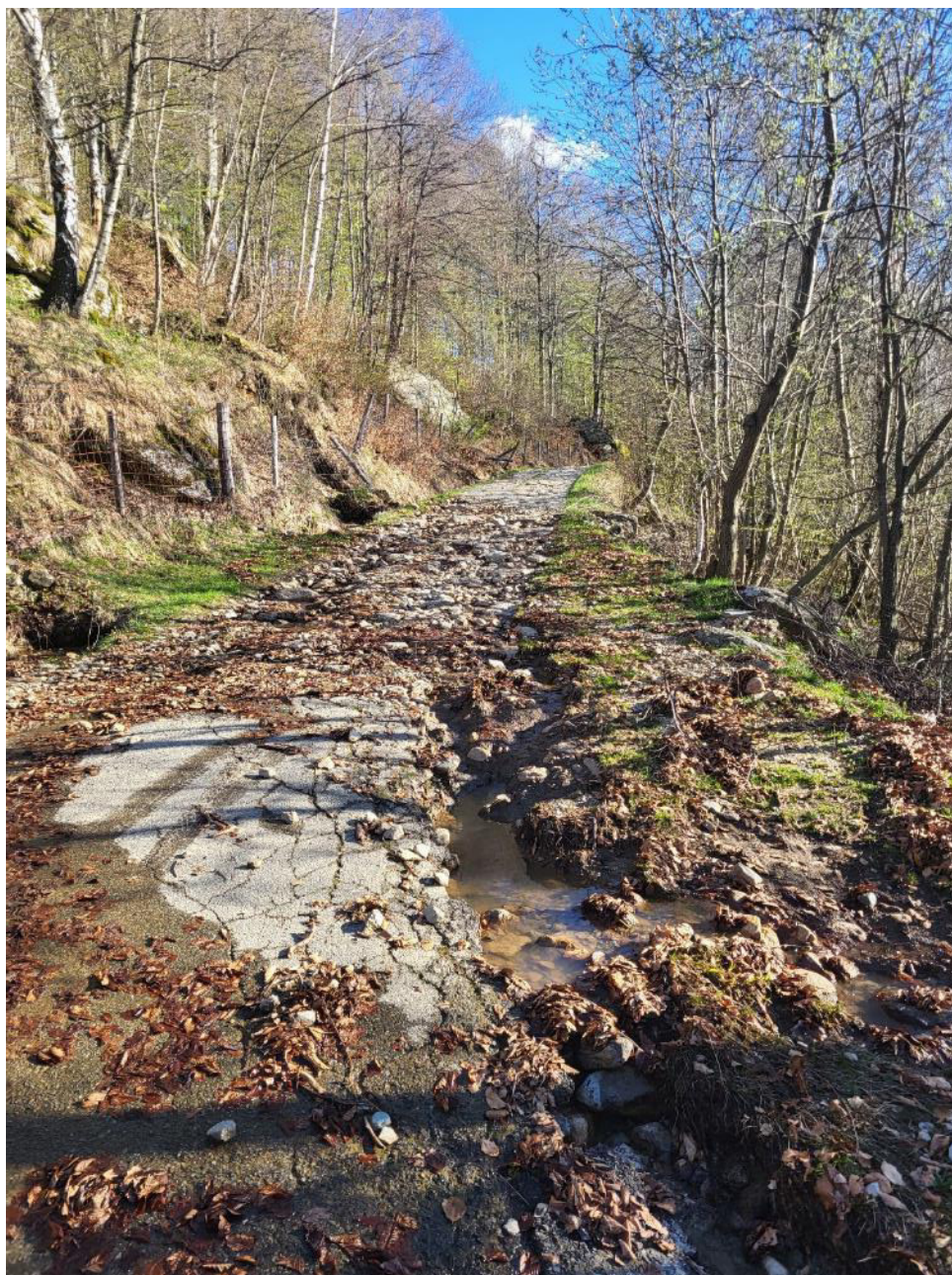
Foto 15: colate detritiche ed importanti cedimenti superficie stradale da ruscellamento sotterraneo.
