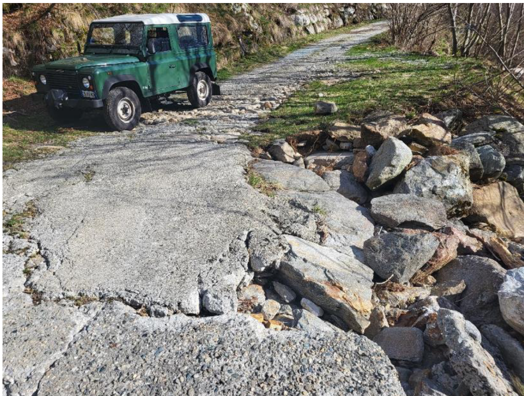
Foto 13: Degrado della superficie stradale.
