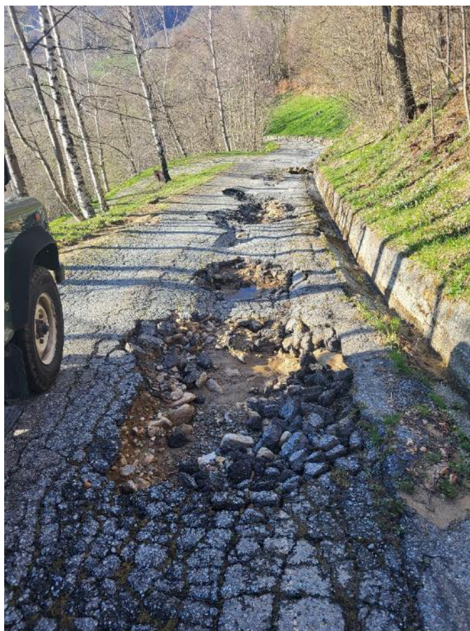
Foto 9: importanti cedimenti superficie stradale da ruscellamento sotterraneo.
