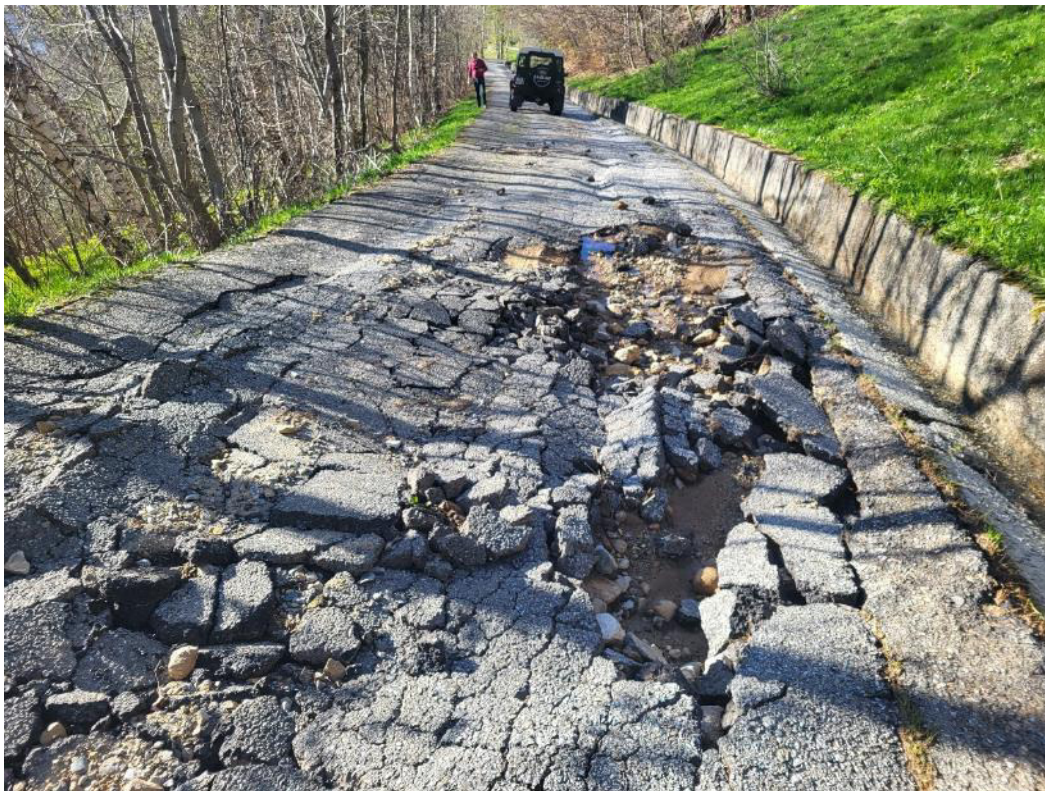
Foto 8: importanti cedimenti superficie stradale da ruscellamento sotterraneo.
